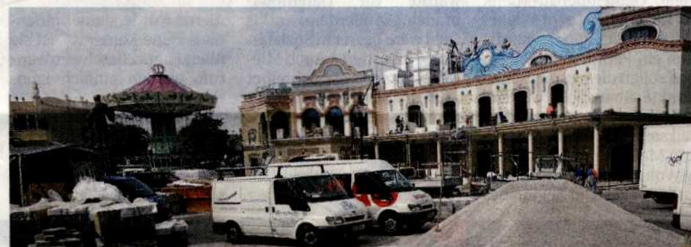
Die Kitsch-Fassade wird von Top-Architekten kritisiert. Am 1. Mai wird der neue Platz präsentiert
