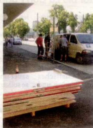
Diese Türen wurden wieder ausgebaut und abtransportiert.
