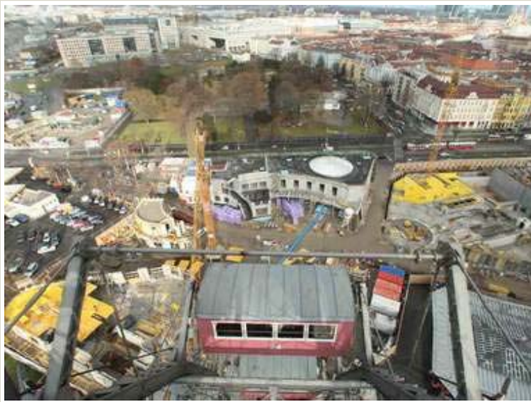
Baustelle beim Riesenrad.
