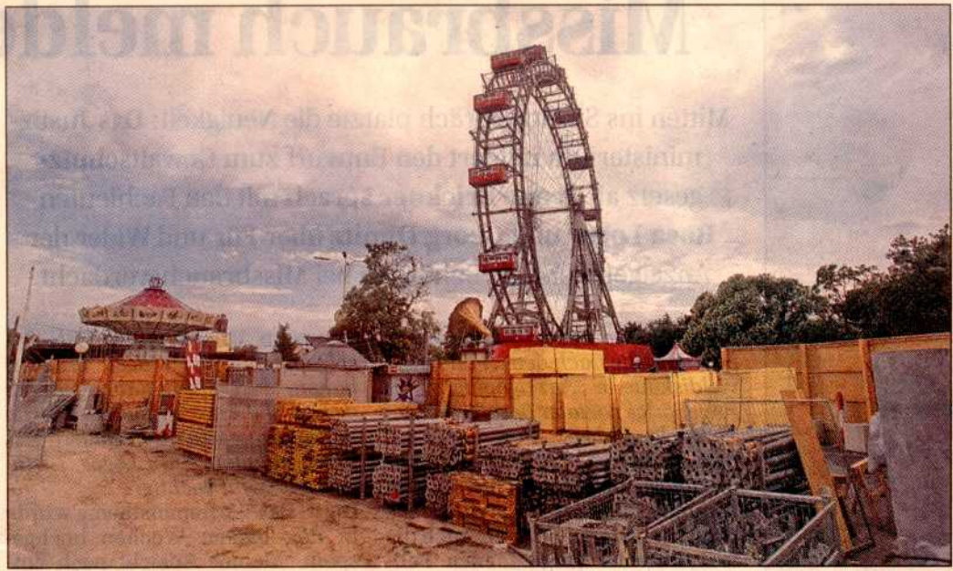
Ein Jahr wurde am Pratervorplatz gebaut, einige Baufirmen warten noch immer auf ihr Geld.
