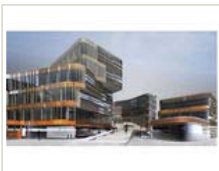
Institutsgebäude vom Engländer Peter Cook
