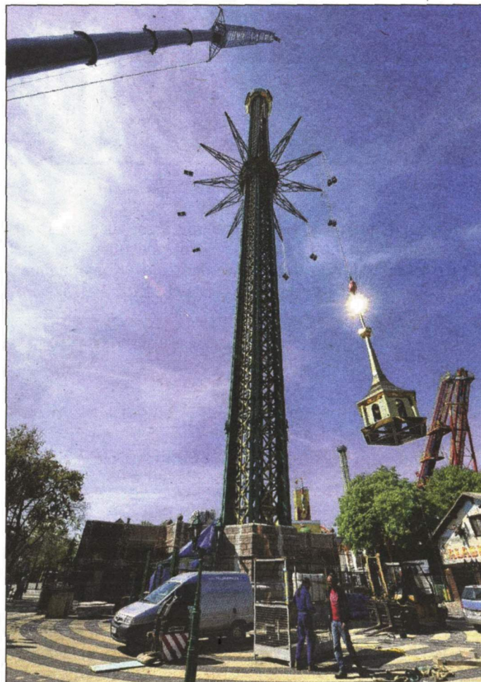
Luftige Höhen Seit Donnerstag steht im Wiener Prater das welthöchste Kettenkarussell: Mit der Montage der Kuppel hat der Gigant seine endgültige Höhe von 117 Metern erreicht. Ein 500 Tonnen schwerer Kran hat den vierteiligen Aufbau des neuen Praterturms in schwindelnde Höhen transportiert.
