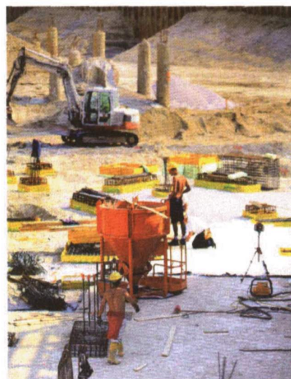
Seit 2010 wird am Rohbau gearbeitet, im Herbst 2013 soll der Regelbetrieb starten
