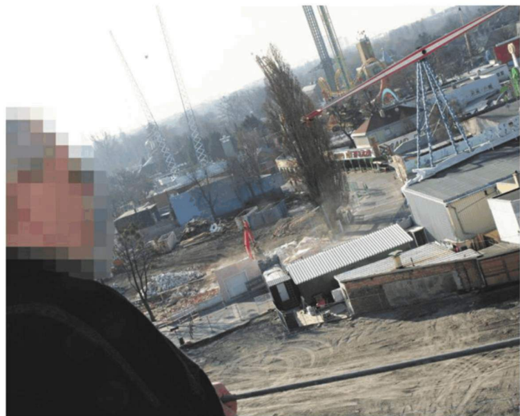
Verzweifelt blickt Anrainer Robert G. auf die Baustelle, wo die Pratergarage und das neue Casino entstehen.
