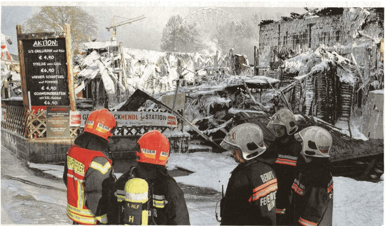
Feuer, Wasser, Löschschaum und ein Bagger – in diesem Trümmerhaufen ist die Suche nach einer Brandursache mehr als mühsam
