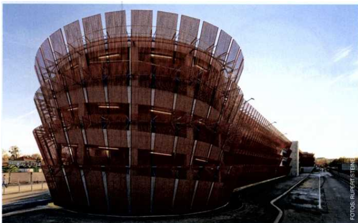
Das Parkhaus umfasst vier Ebenen und wurde 2013 errichtet und eröffnet
