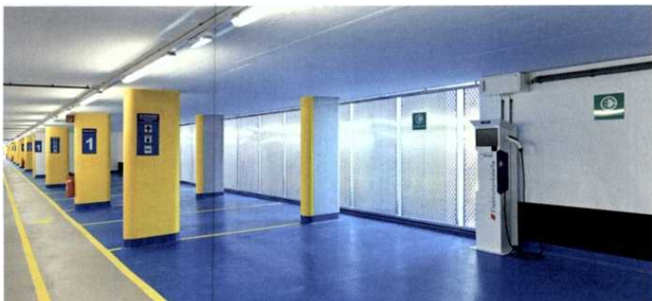
Die Garage bietet Platz für 370 Pkw-, 37 Motorrad-Stellplätze und 16 Elektroladestellen.
