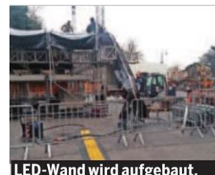
LED-Wand wird aufgebaut.
