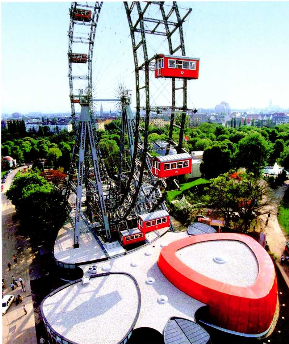
Um den Unterbau des Wiener Riesenrades gruppieren sich mehrere Pavillons. So entsteht ein „Riesen-Räderwerk aus großen und kleinen Rädern“. Für den neuen Gebäudekomplex lieferte Viessmann die Heiztechnik.
