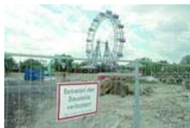
Vor dem Riesenrad wird schon gebaut – und alle fragen sich, was genau. Foto: Ziegler
